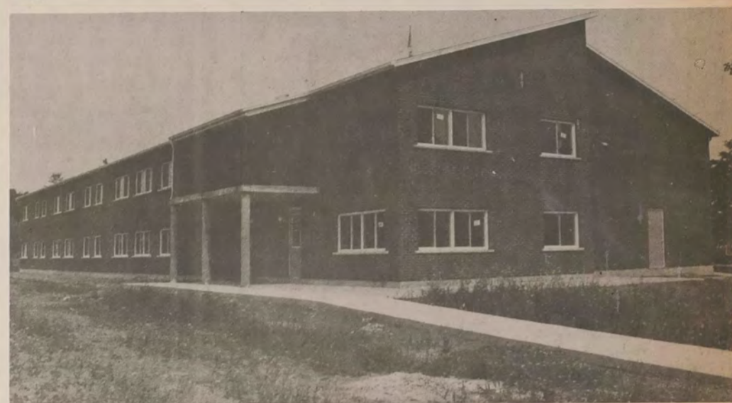
Le Foyer St-Félix, qui comprend 21 logements, est prévu pour les personnes de 55 ans et plus, dont les revenus sont modiques.
