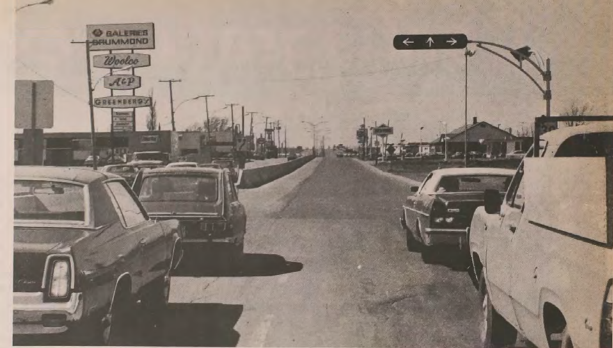
Sur la photo, les trois flèches indiquent le fonctionnement du système d'arrêts périodiques, selon la direction des automobiles.
