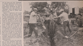
TRAVAUX DE DRAINAGE
