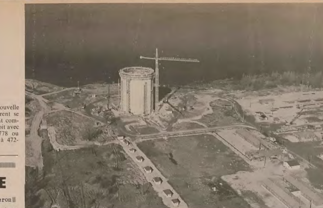
CENTRALE NUCLÉAIRE DE GENTILLY On aperçoit sur cette photo l'édifice d'une hauteur de 150 pieds qui abritera le réacteur nucléaire de la Centrale de Gentilly. Grâce à l'emploi de la forme coquille et du béton précontraint, une méthode de construction utilisée pour la première fois en Amérique, l'érection de ce bâtiment a été réalisée en moins de 18 jours. On sait que cette Centrale nucléaire est la première du genre implantée au Québec grâce à une entente entre l'Hydro-Québec et l'Énergie atomique du Canada limitée.
