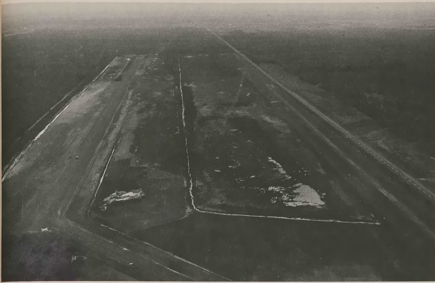
LES TRAVAUX SONT TERMINÉS À L'AÉROPORT
