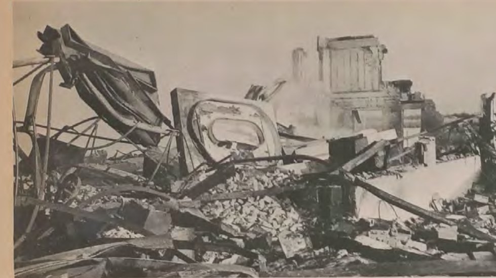
Cette photo n'a rien à voir avec Coventry après les bombardements allemands. Cette scène de démolition représente plutôt tout ce qui restait, mercredi dernier, en fin d'après-midi, du fameux hôtel du Moulin-Rouge, incendié au début de la journée...
